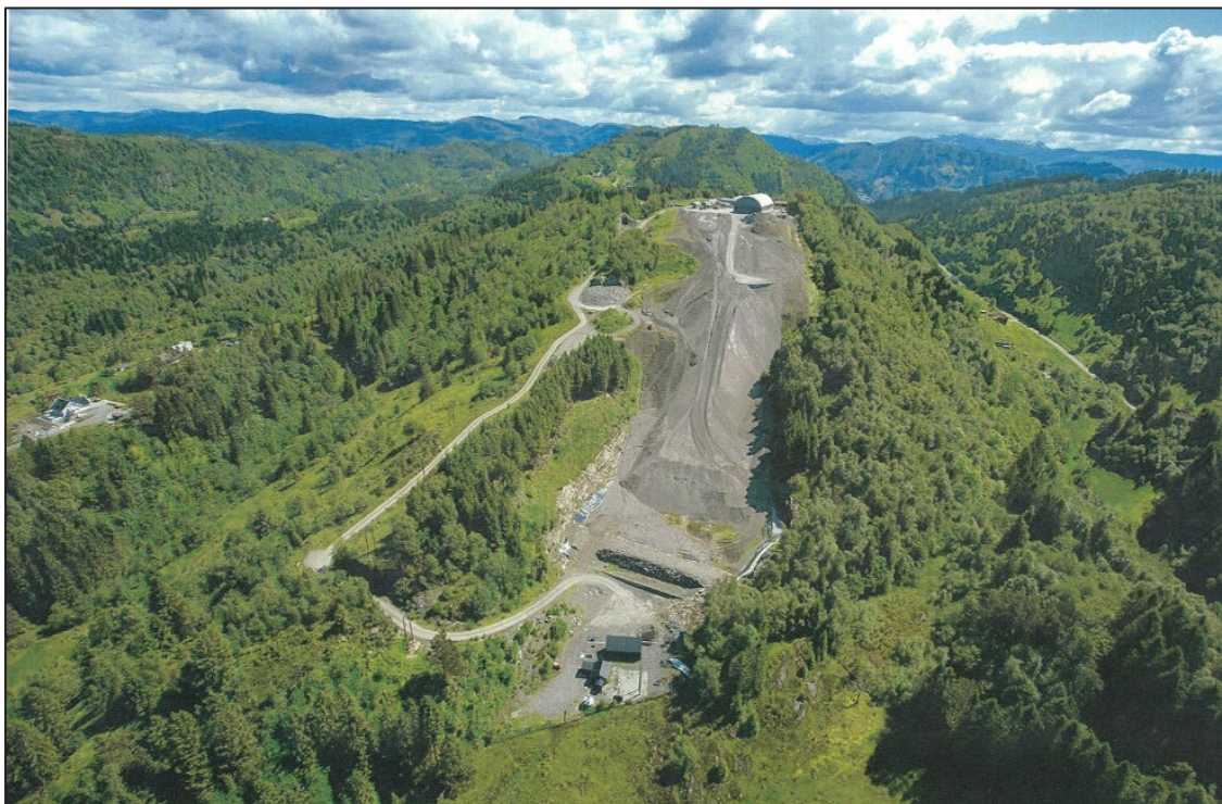
Figur 3-5 Flyfoto av Mjelstad deponi sett frå nord
