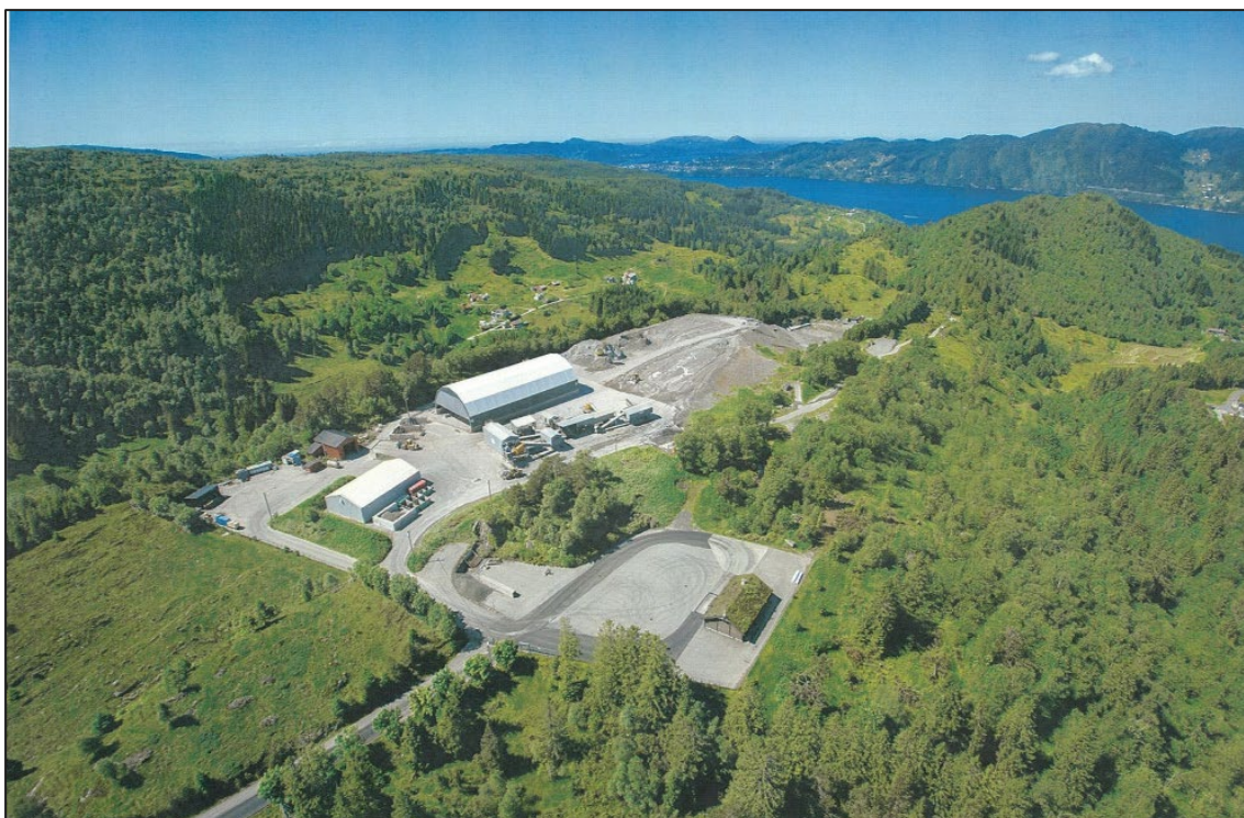
Figur 3-6 Flyfoto av Mjelstad deponi sett frå søraust.
