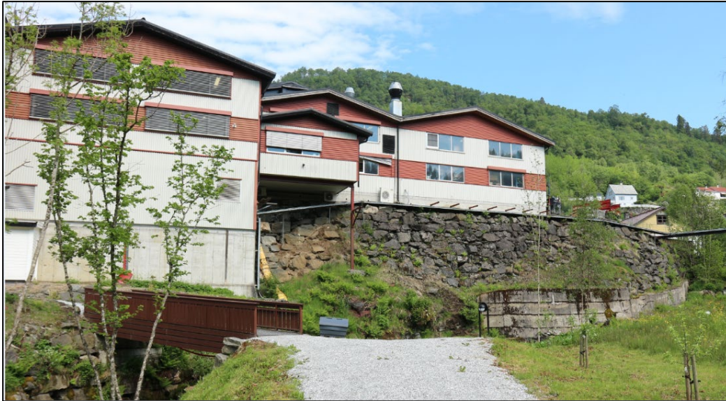
Figur 36: Mur2 (sjå figur 31) langs Holeelva (Opus, juni 2016)
