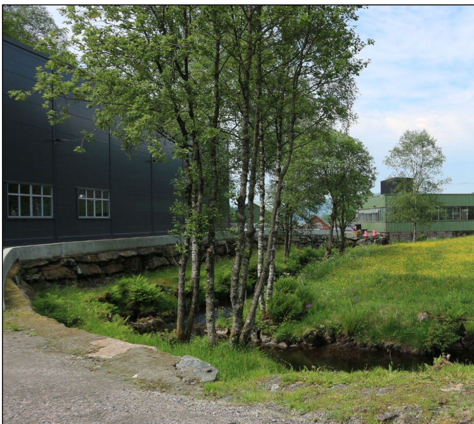
Figur 35: Mur1(sjå figur 31) langs Holeelva (Opus, juni 2016)
