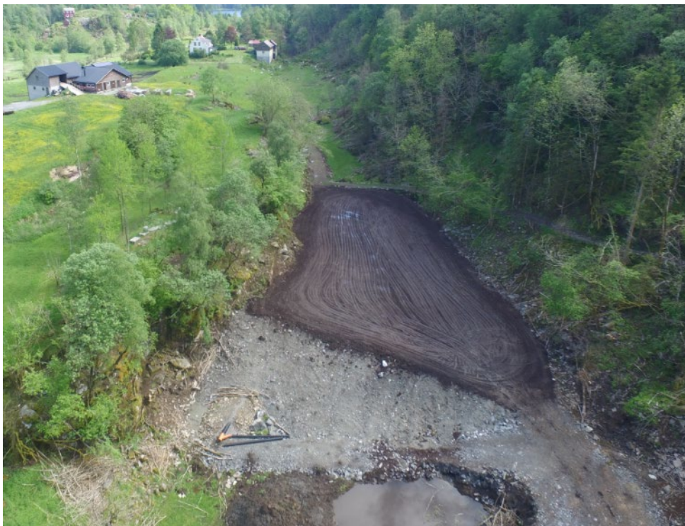
Figur 20 Overskotsmasse for planering av dyrka jord bak planområdet. Biletet er tatt i sørleg retning. (Opus Bergen, juni 2016)
