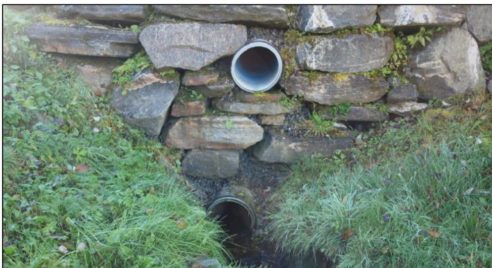
Figur 34: Dreneringsrøyr frå mindre bekk til Holeelva (foto: Geolog AS, 2016)
