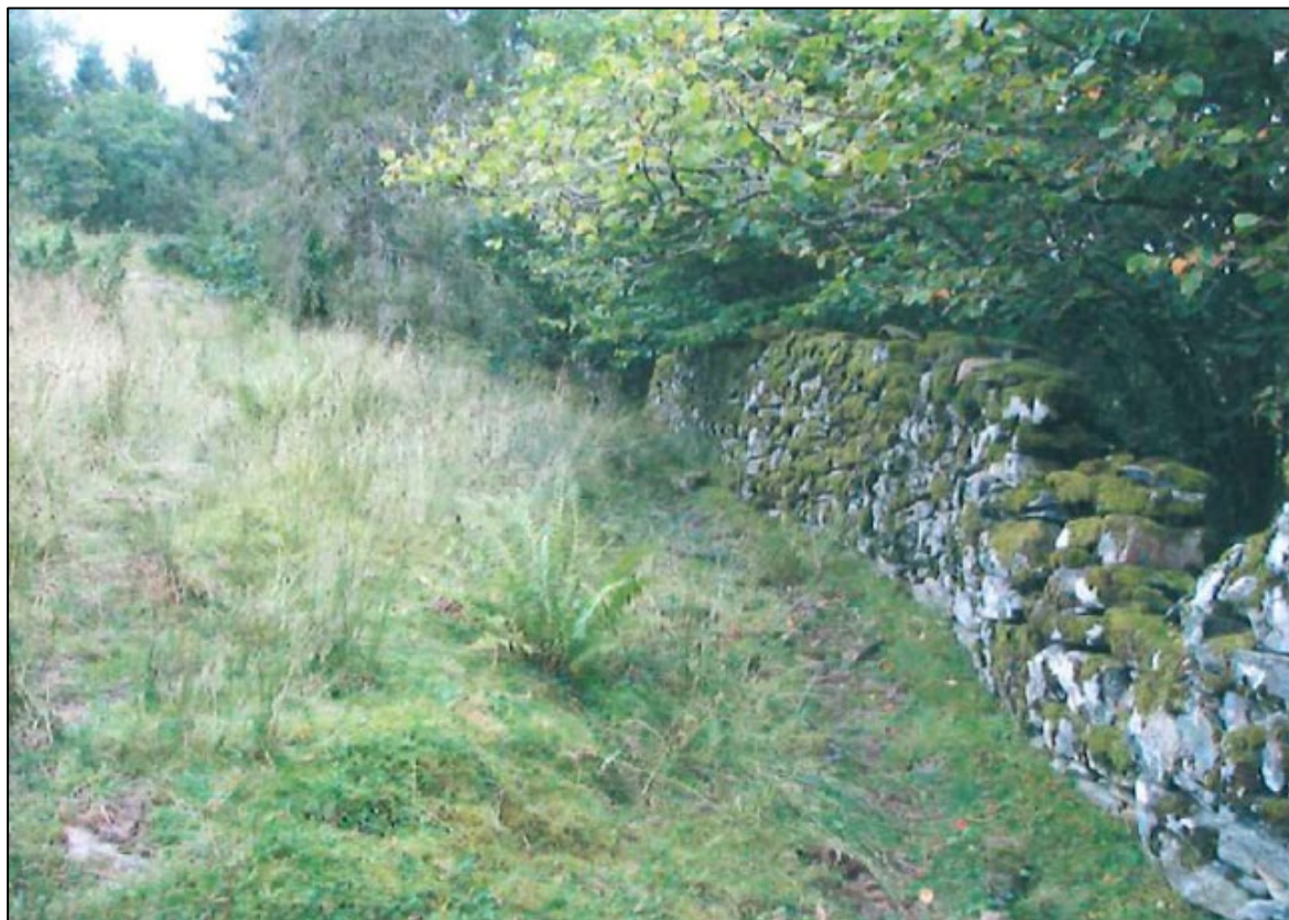
Figur 26: Steingard på oppsida at det nyaste næringsbygget (Multiconsult, 2008)
