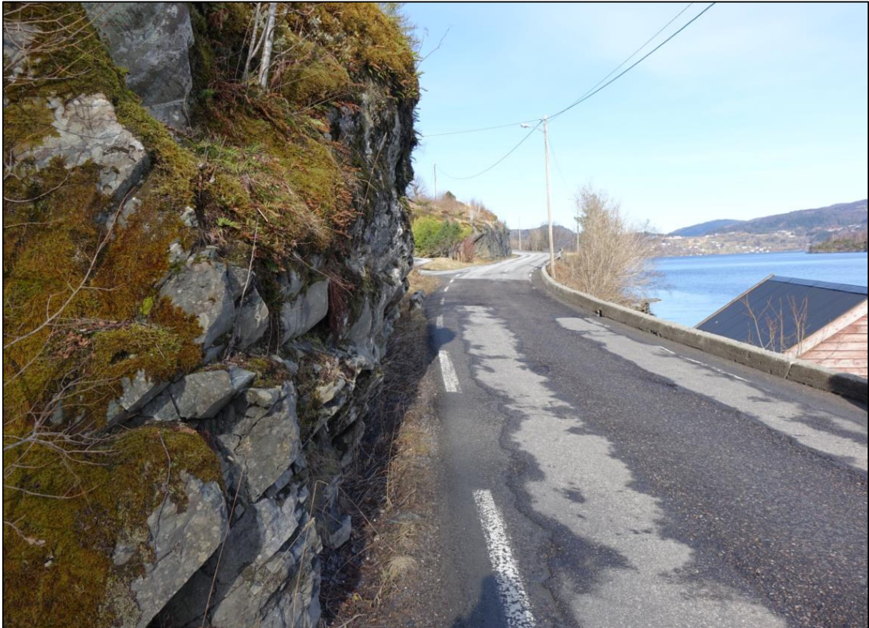
Figur 19: Skjæring lengst nord i planområdet.
