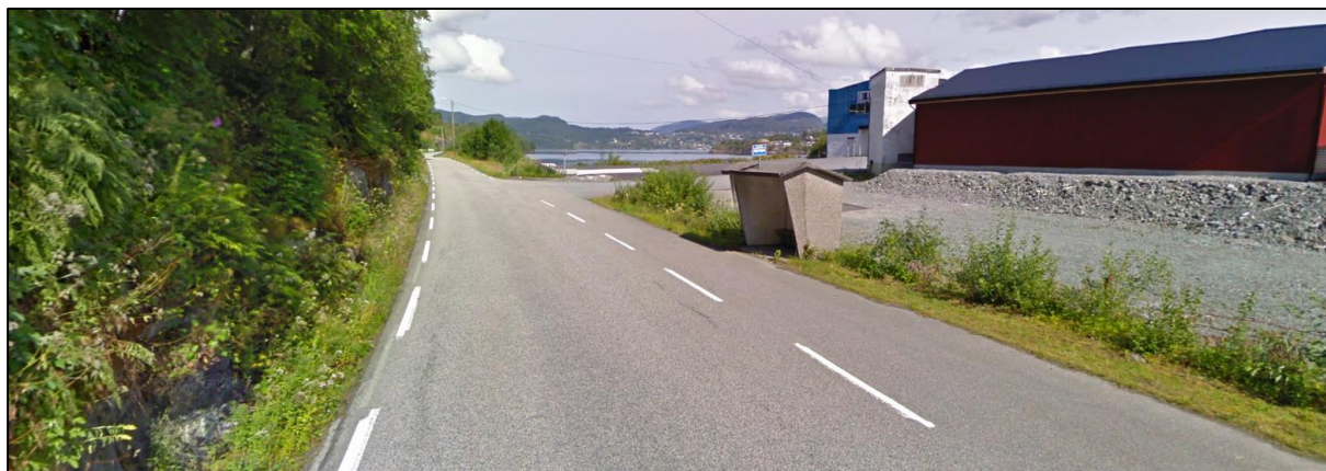
Figur 6-23. Bilete som visar eksisterande busshaldeplass og trafo(kjelde: Google maps)
