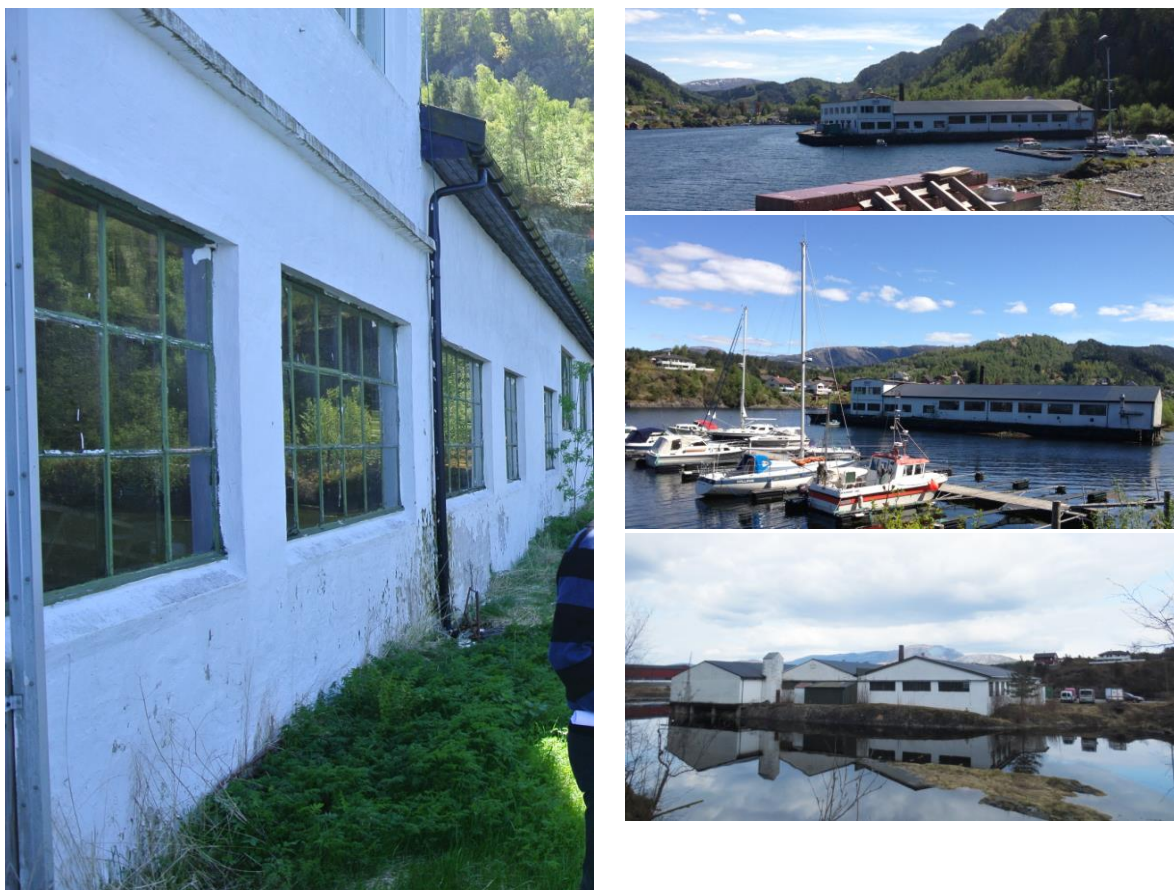
Figur 6-15. Bilete av HBH-bygget, bygd 1944.
