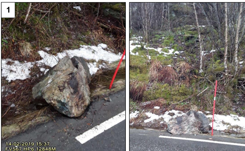
Figur 13 Steinsprang som inntraff 14.02.2019. Bilder fra Statens vegvesen.
