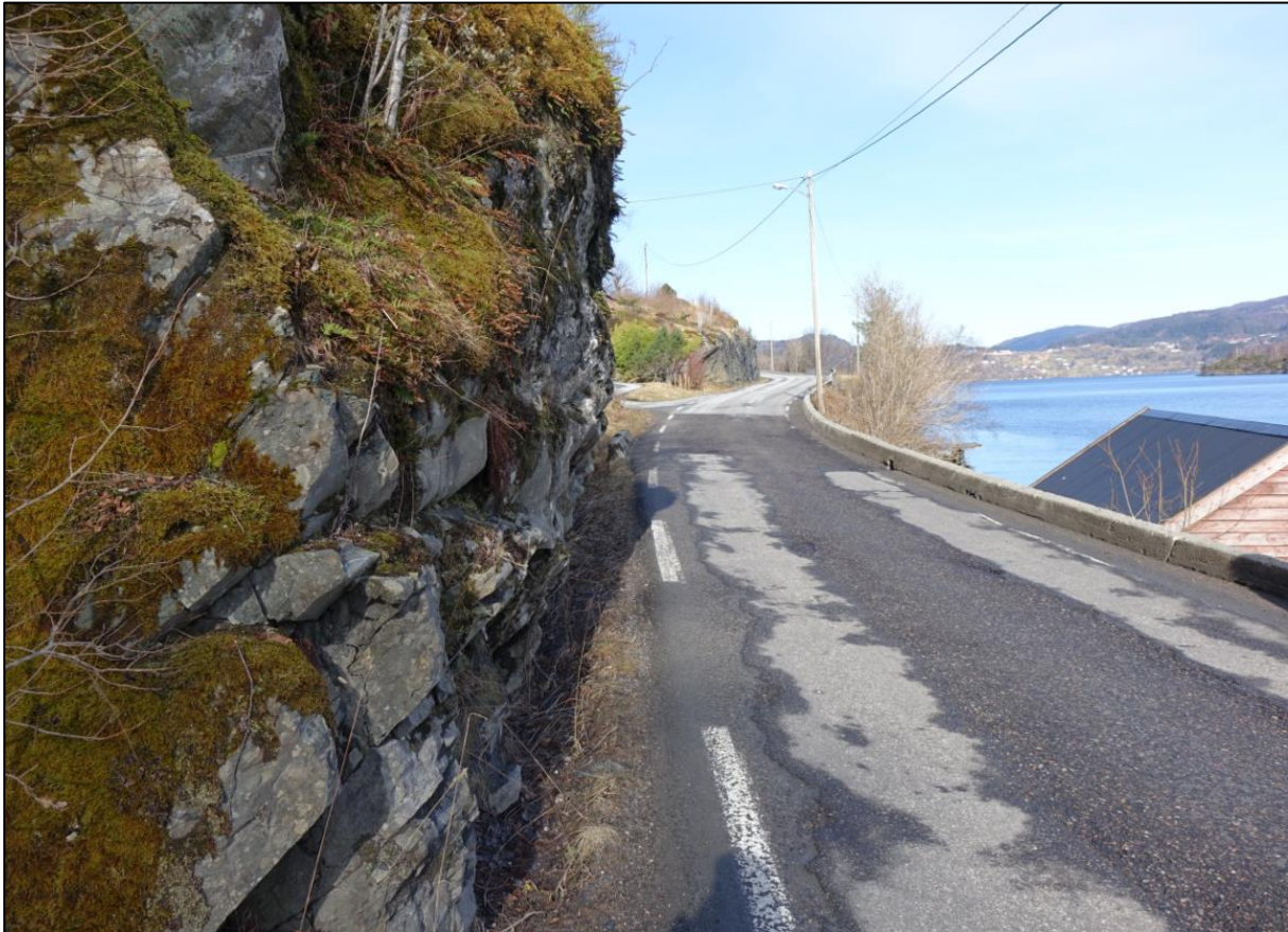
Figur 19: Skjæring lengst nord i planområdet.
