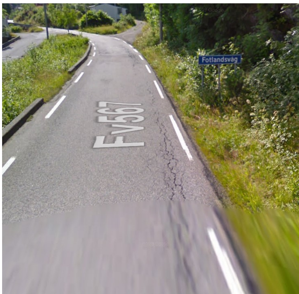
Dagens situasjon: Enkel vegbane utan fortau forbi planlagt næringsområde
