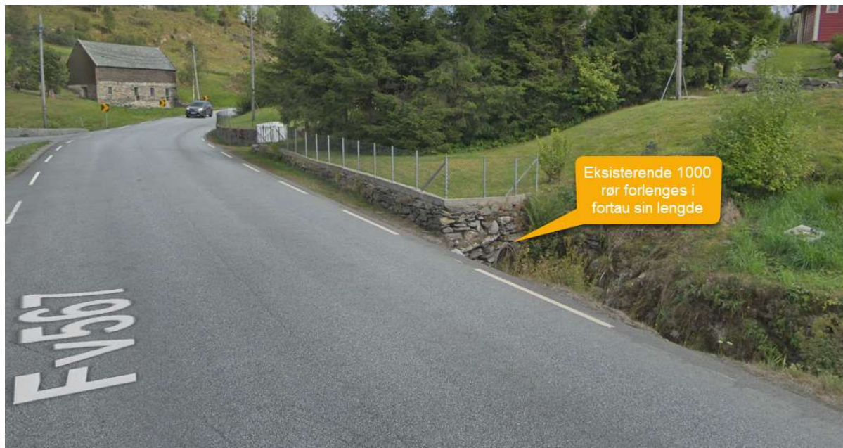
Figur 15 Utløp for eksisterende kulvert
