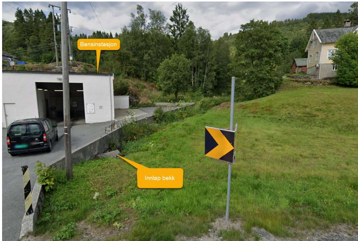
Figur 8 Bilde som viser bekkeinntak for DN1000BET som krysser Fv567 ved bensinstasjon
