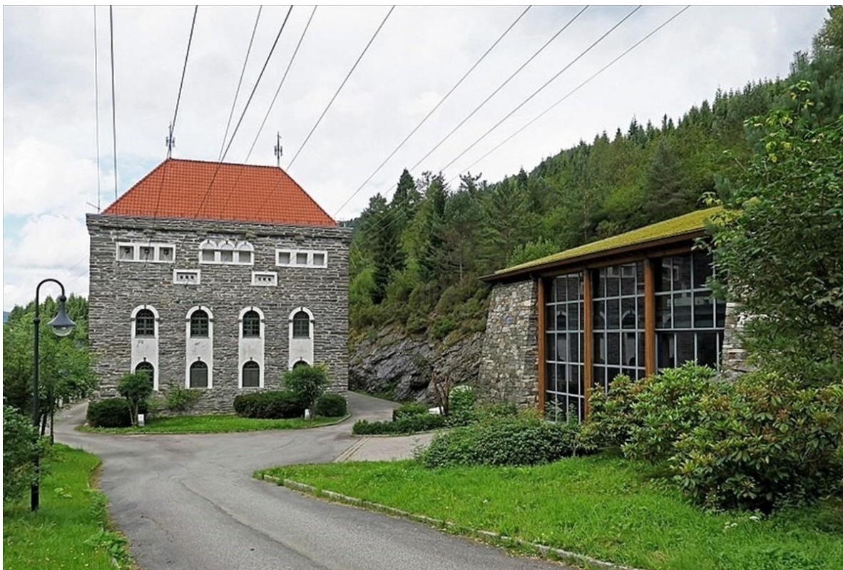
Herlandsfossen kraftverk. Arena for ny DKS-oppsetting for 8. klasse. Foto: BKK
