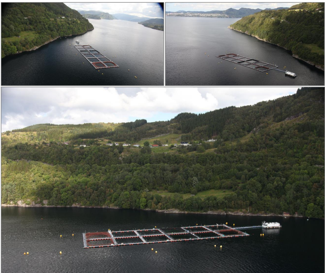
Figur 19. Bilde av lokaliteten Angelskår og då anlegget besto av merdar av stålbur (før 2017).
