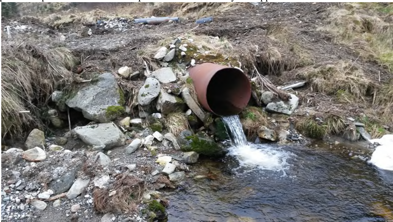
Figur 52 Vassføring i sjølv bekken (eksisterande, gammalt røyr under skogsveg)
