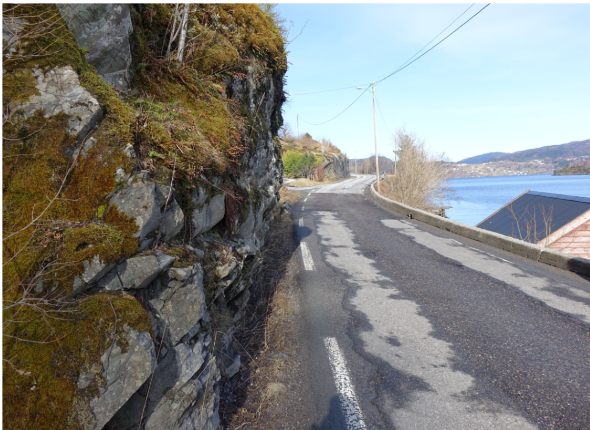
Figur 14: Skjæring lengst nord i planområdet.
