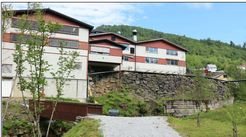
Figur 36: Mur2 (sjå figur 31) langs Holeelva (Opus, juni 2016)
