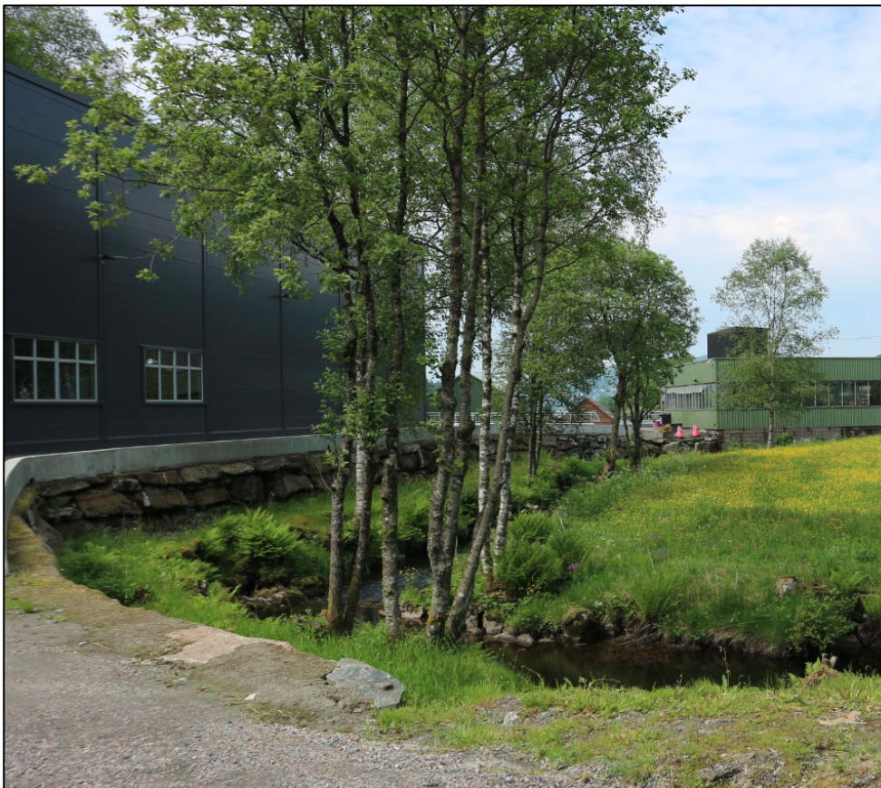
Figur 35: Mur1 (sjå figur 31) langs Holeelva (Opus, juni 2016)
