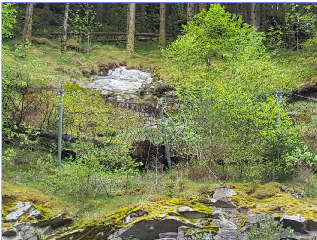
Figur 4. Bilde av skråning over tunnelåpning ved industriområdet i sørvest av utredningsområdet. En rotvelt har eksponert berg under et tynt vegetasjonsdekke.
