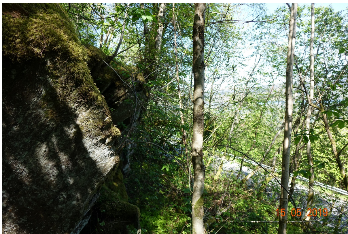
Figur 8: Skrent med avløyste blokker lokalisert ved GPS-punkt 1124.
