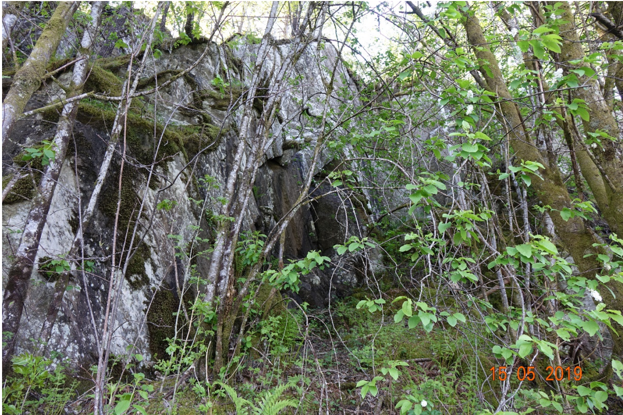
Figur 15 Relativt lite oppsprukken skjering.
